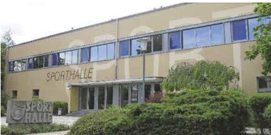
Vom grauen Betonklotz zum attraktiven Sportzentrum: ein Projekt, gedämmt und gestaltet vom Malerbetrieb Ziegler.
