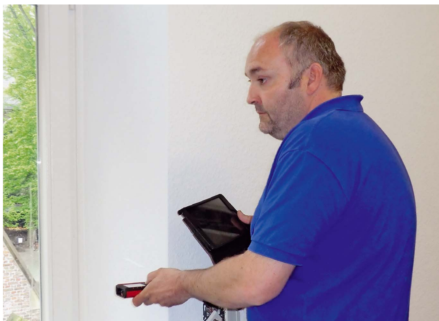
Fenster sind im Nu aufgemessen, einmal senkrecht, einmal waagrecht messen – fertig.
