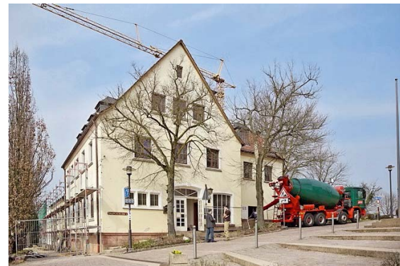
Ein großer Gebäudekomplex: Weil die Fassade teilweise nur schwer zugänglich war, kam außen das Fotoaufmaß zum Einsatz.
